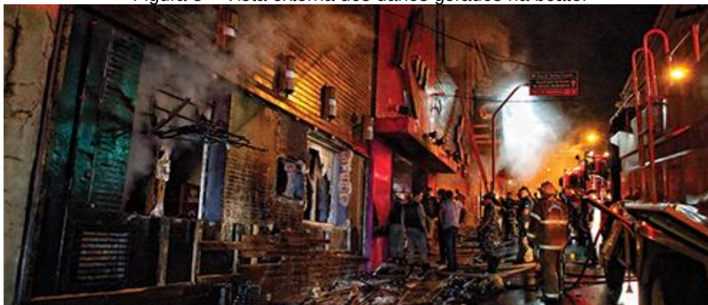
Figura 3 – Vista externa dos danos gerados na boate.
